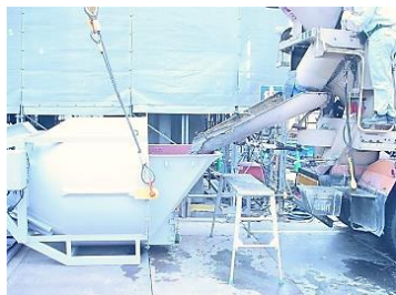
コンクリートミキサー車からコンクリート投入！
