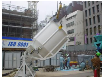
吊り上げていきます♪
