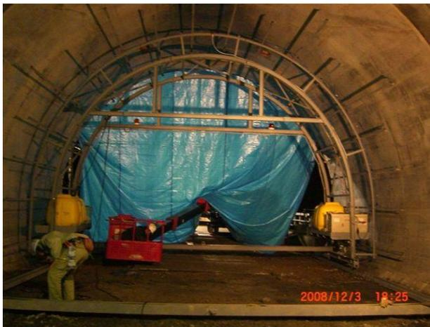
トンネル散水養生装置全景
