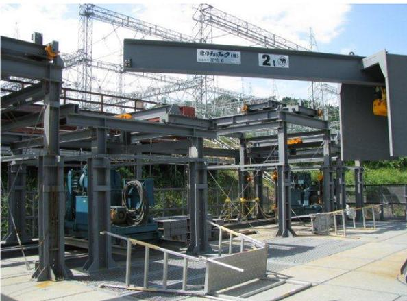
変電所内の法面補強工事のため、鋼管杭を打設する機材を搭載し、全長約400mを移動しながら施工する設備です。
