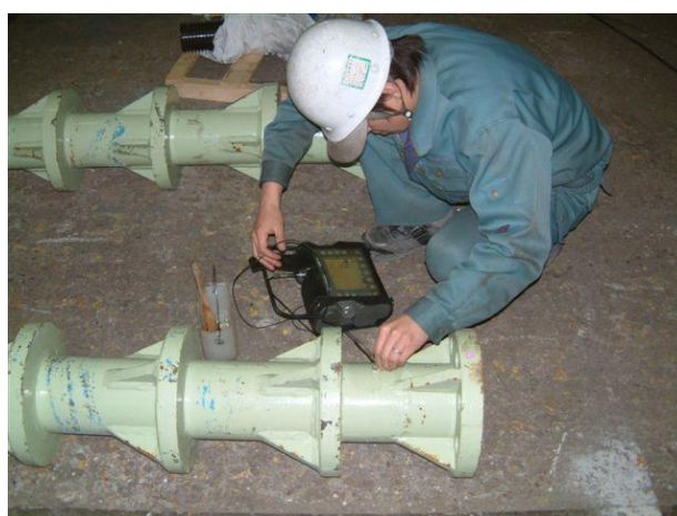
テンションバー超音波検査状況
