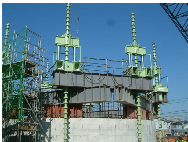
K-G圧入装置現場設置状況
