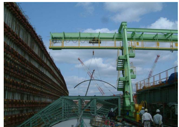
8m張り出し部
