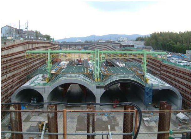
ツインクレーンとめがねトンネル施工
