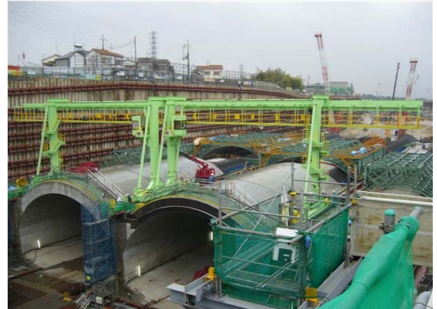
L形クレーン全景
