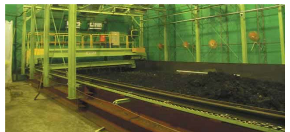
土壤改良ヤード
