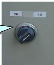
制御盤側面のセレクトスイッチを無線又は有線に切替えて下さい
