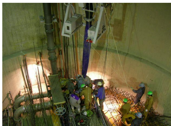
立坑内のコンクリート打設状況
