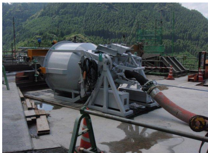
ダム工事のコンクリート打設
