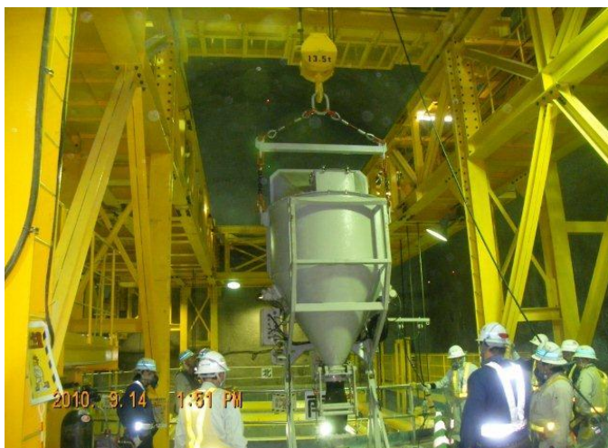
トンネル工事のコンクリート打設
