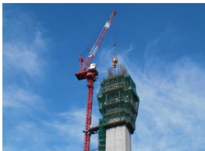
スーパーRC工法による橋脚施工
